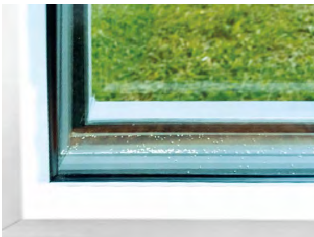
Beispielfoto zulässiger Trocknungsmittel-Rückstände
