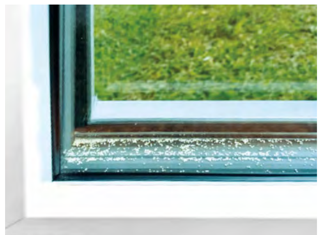
Beispielfoto nicht zulässiger Trocknungsmittel-Rückstände
